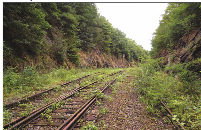
Železniční zářez u Střezimíře více než dva roky po jeho opuštění.
